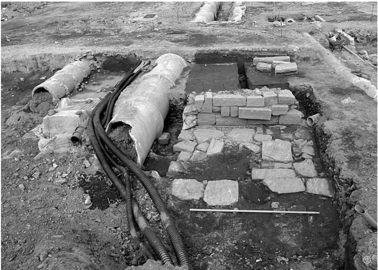
사진 7. 신평교 교대지 조사전 전경(①), 노출 전경(②)
