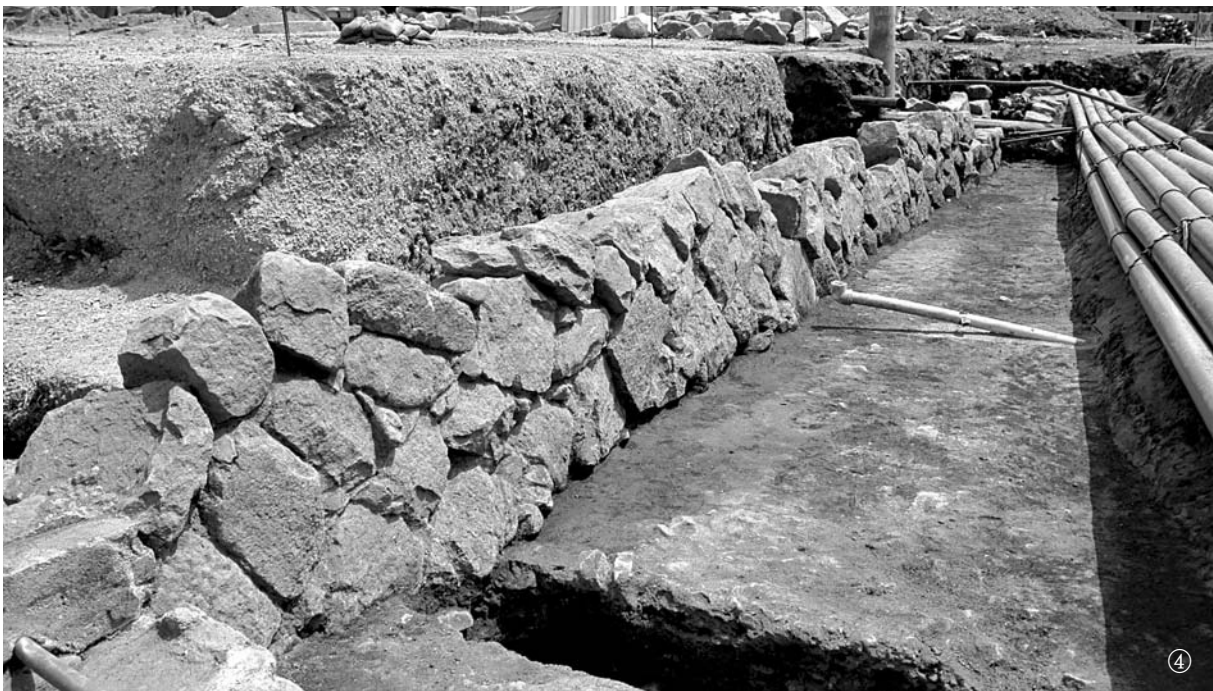
사진 5. 남측 호안석축 항공사진(①), 전경(②~④)
