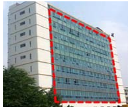
제2별관 그린리모델링 공사 시행부위
