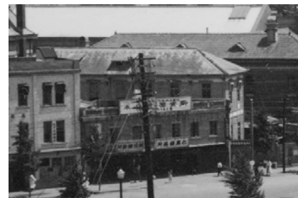
① 건물 (01-01-07-m1026-06_유리건판)
