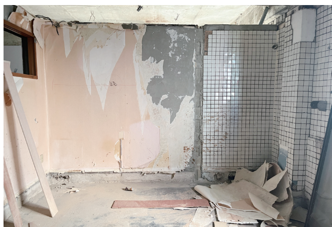
공사 중인 교차공간818
