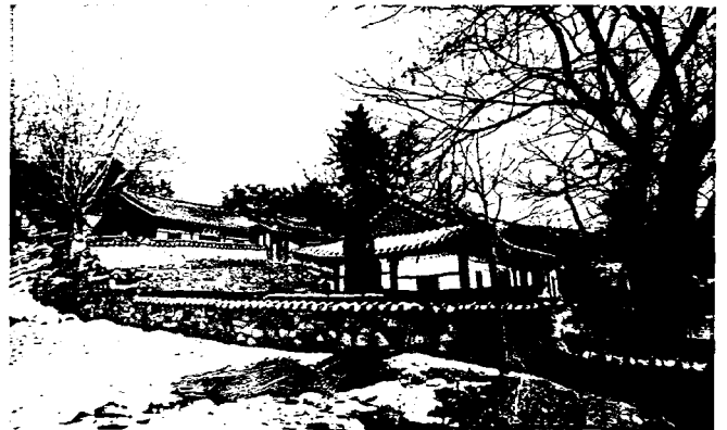
명륜당 영역 담장 설치(1987년 이후) (「지평향교 문화재현황」, 양평군)
