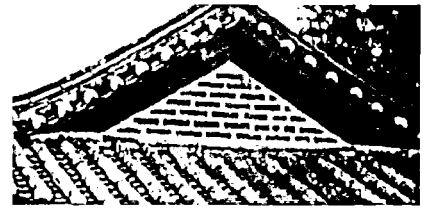
1989년 공사후 명륜당 합각부 (「지평향교 보수(명륜당보수)」(1), 1989, 국가기록원)
