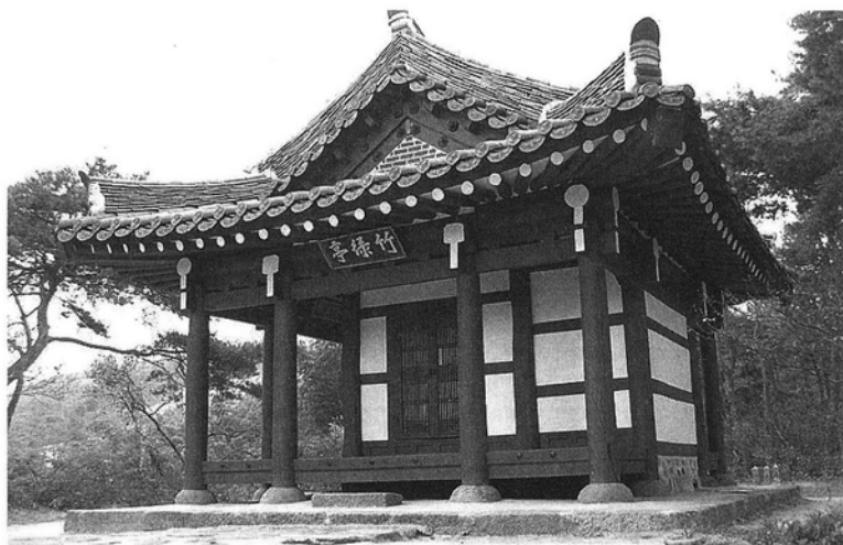
고서면 원강리의 송강정 전경(죽록정으로도 불림)
