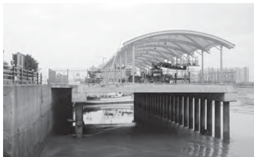
물량장 공사 마무리 중
