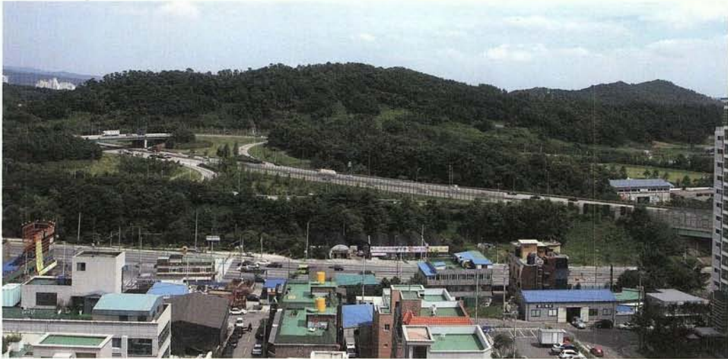
영동고속도로 대이미동 구간
