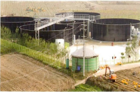
Site : Yeo-Ju County Material : Porcelain Enamel Capacity : 2,000 m 3 X 5 units(80 m 3 /day) Date : 2006. 12
