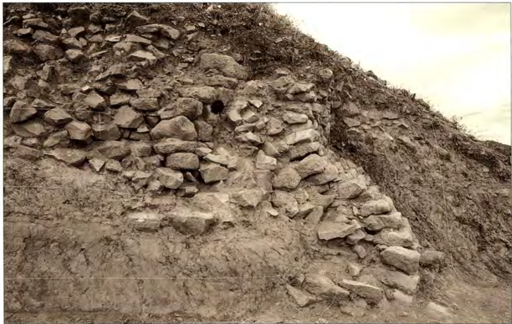
〈그림2〉 연천 호로그루 성벽(토축을 한뒤 석축을 하고 그 기저부에 보축을 하였다)
