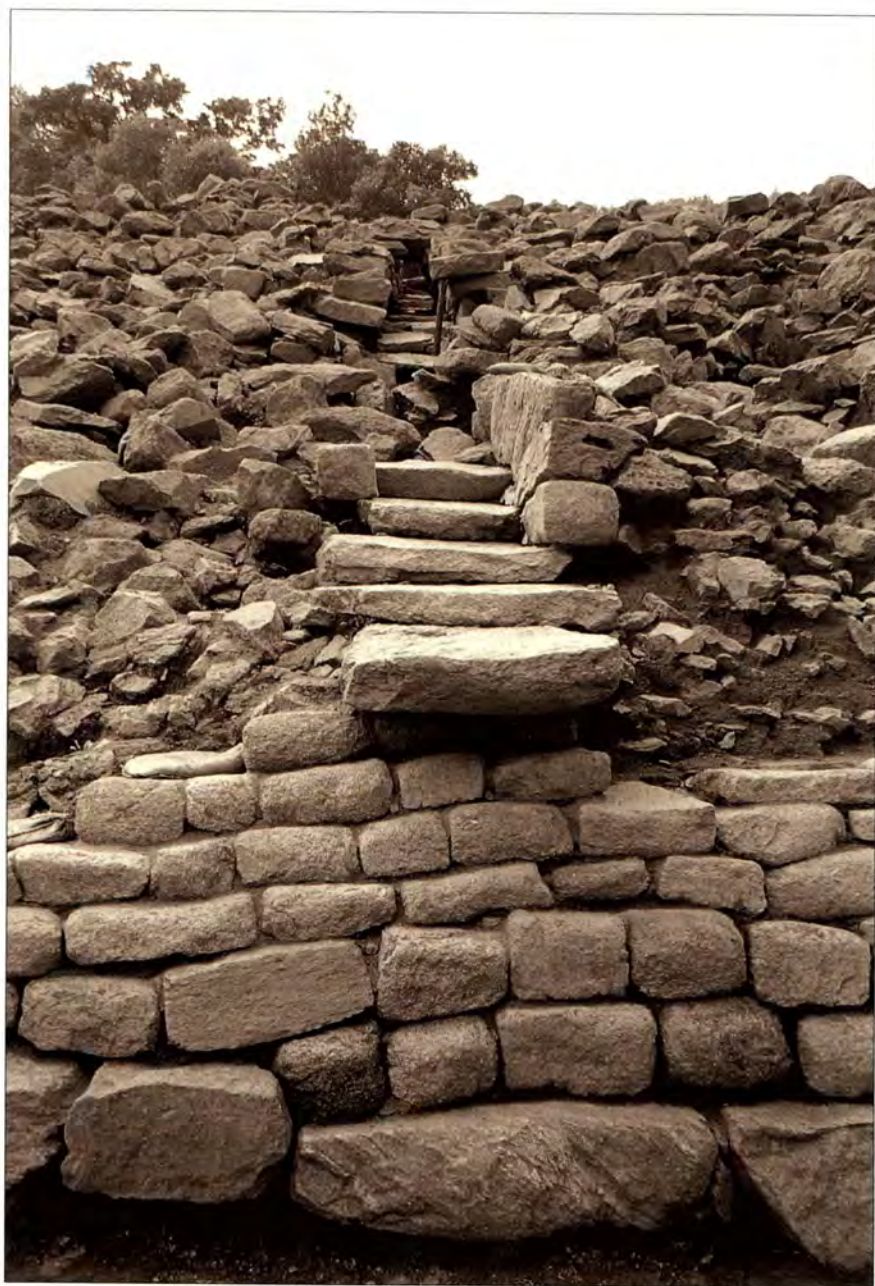
〈그림 8〉 하남 이성산성 남벽의 계단식 수구
