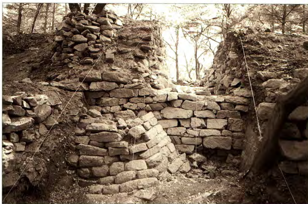
〈그림 24〉 서울 아차산성 동문지(현문식 구조이며 문바깥쪽에 웅성처럼 둥글게 보축성벽을 쌓았다.)
