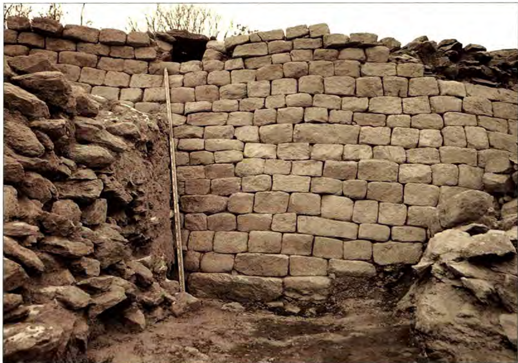
〈그림 7〉 하남 이성산성 동문지(현문식이며 바닥에 수구가 조성되어 있다.)
