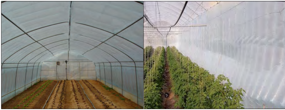
그림 1. 공기팩 비닐 설치 전경
