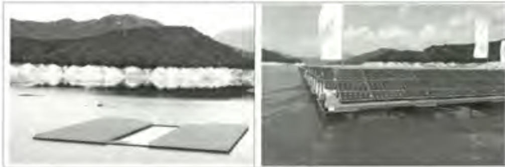
[그림 7-21] 합천댐 500kW 수상태양광 전경
