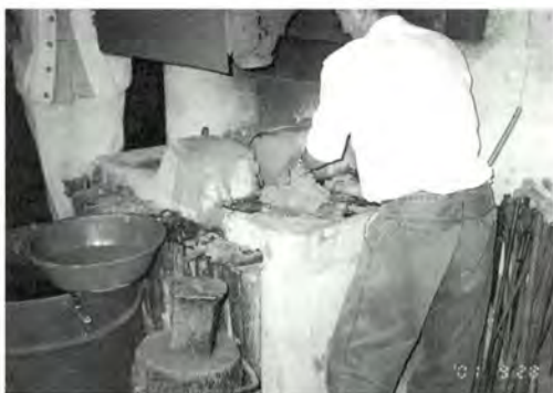
양평읍 양근리 최주열씨 대장간 화덕 보수작업
