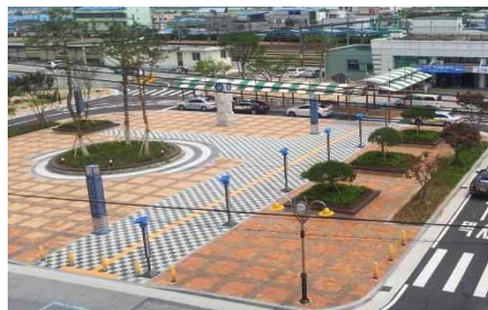
[그림 38] 벤치 및 휴식공간 설치
