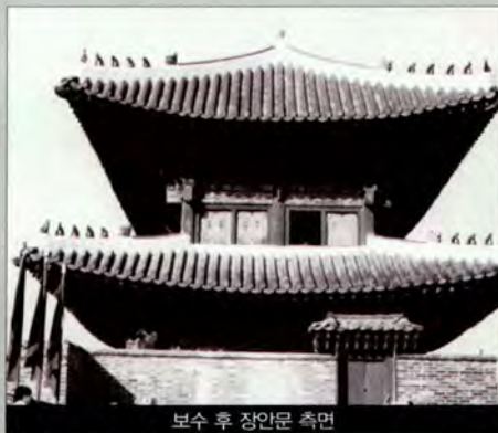
보수 후 장안문 측면
