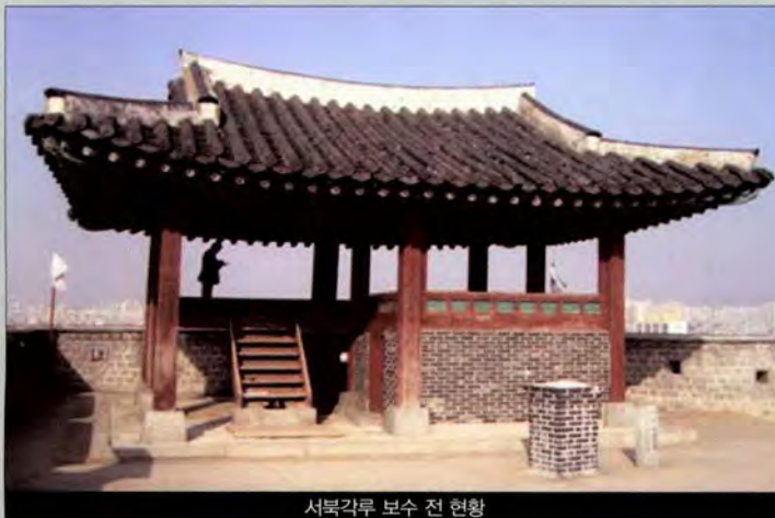
서북각루 보수 전 현황
