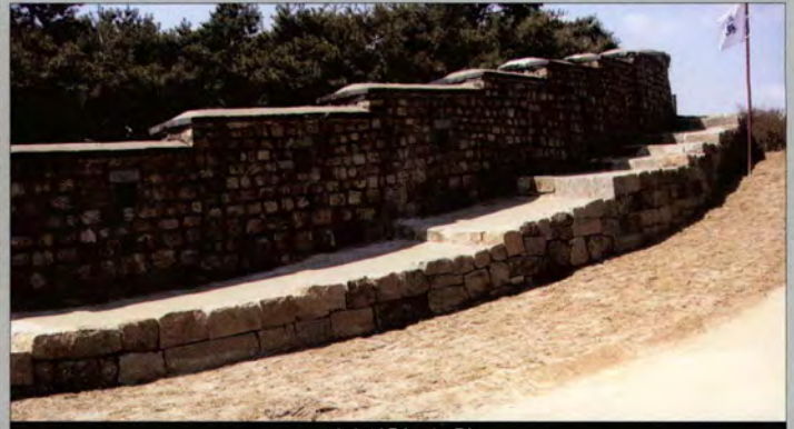
여장 석축(보수 후)
