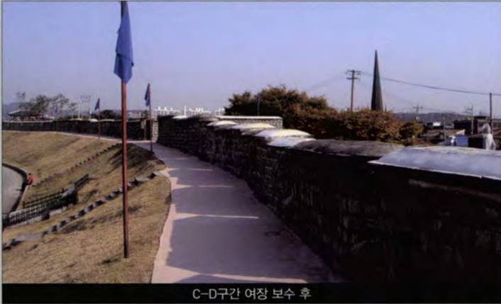
C-D구간 여장 보수 후
