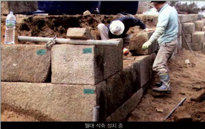
월대 석축 설치 중
