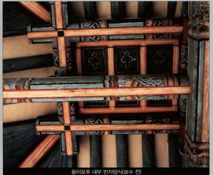
동이포루 내부 반자양식(보수 전)
