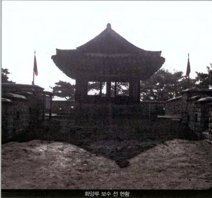
화양루 보수 전 현황
