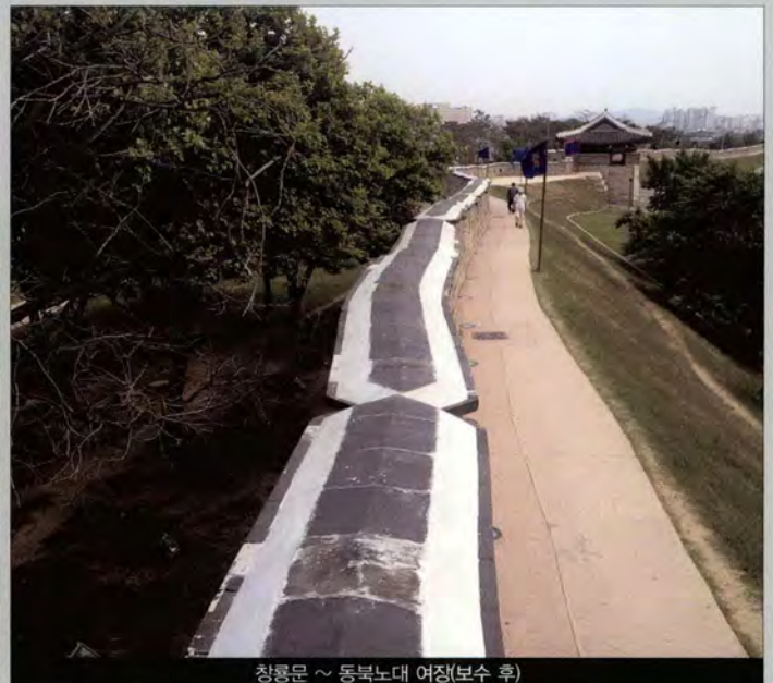
창룡문 ~ 동북노대 여장(보수 후)
