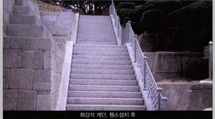
화강석 계단, 웬스설치 후
