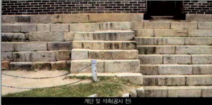
계단 및 석축(공사 전)
