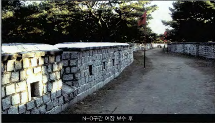
N-O구간 여장 보수 후
