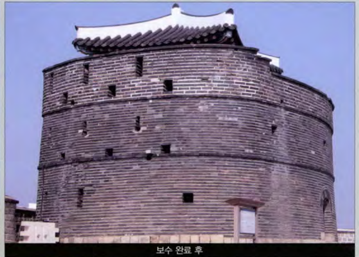
보수 완료 후
