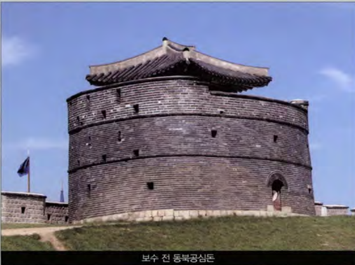
보수 전 동북공심돈
