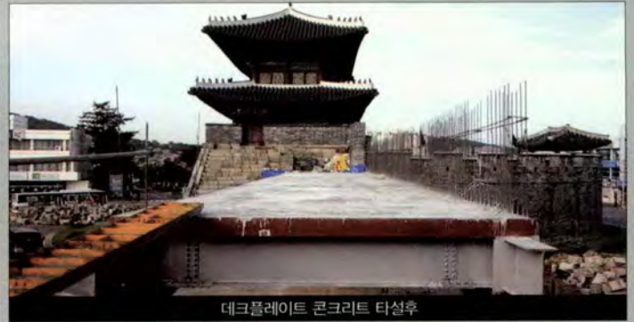
데크플레이트 콘크리트 타설후
