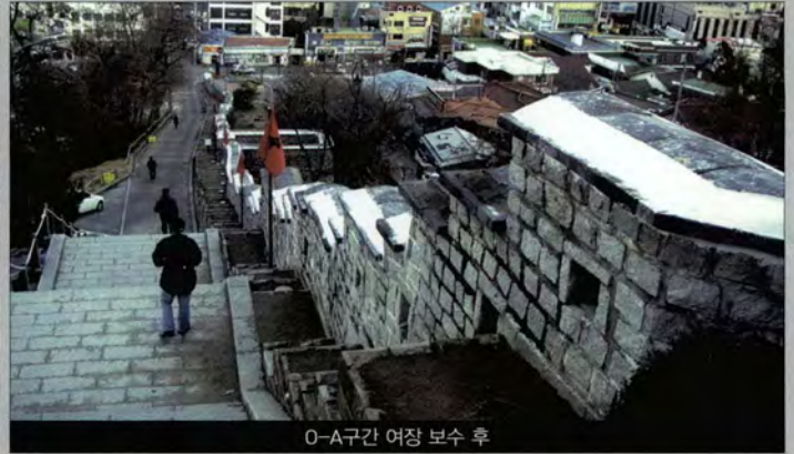
O-A구간 여장 보수 후
