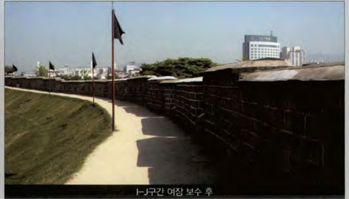
I-J구간 여장 보수 후
