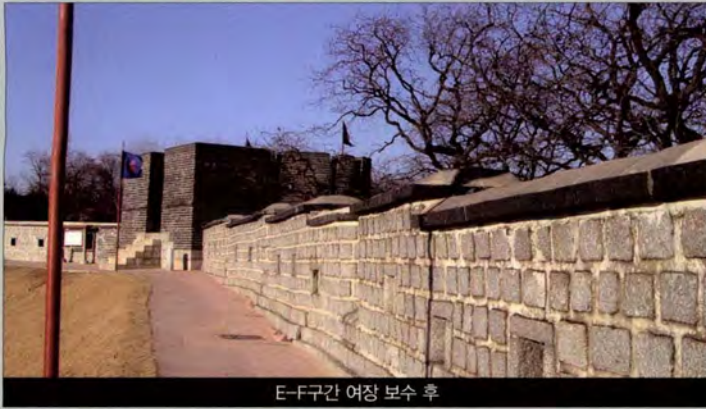
E-F구간 여장 보수 후
