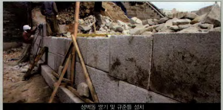
성벽돌 쌓기 및 기준틀 설치
