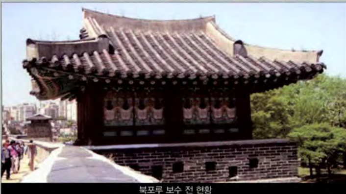
북포루 보수 전 현황
