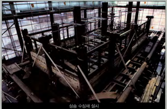
상층 수장재 설치
