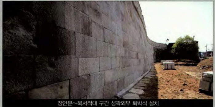
장안문~북서적대 구간 성곽외부 퇴박석 설치
