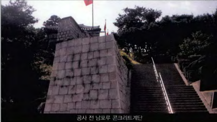
공사 전 남포루 콘크리트계단
