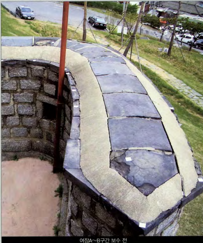
여장A~B구간 보수 전
