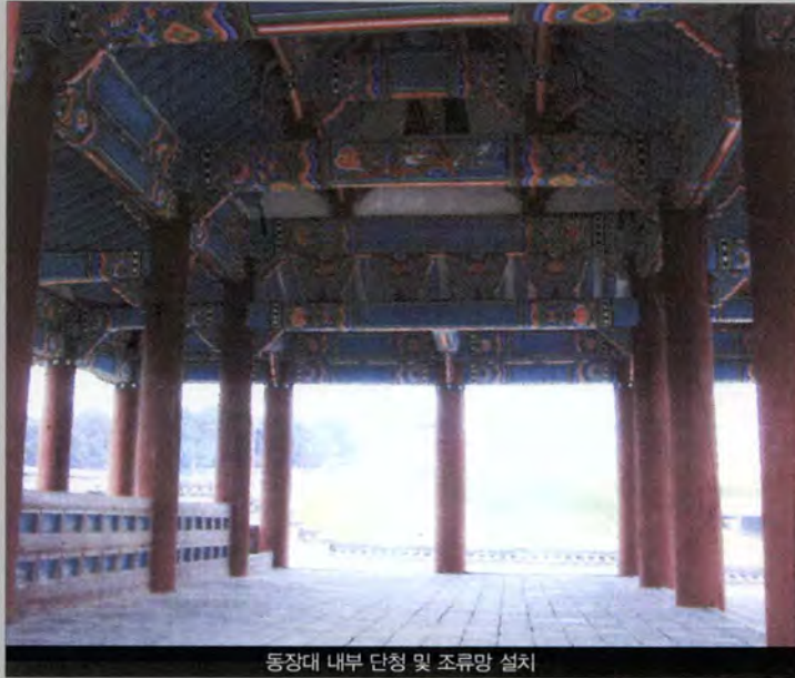
동장대 내부 단청 및 조류망 설치
