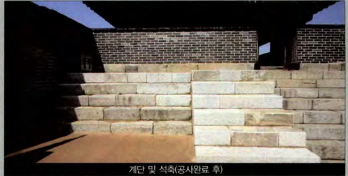
계단 및 석축(공사완료 후)
