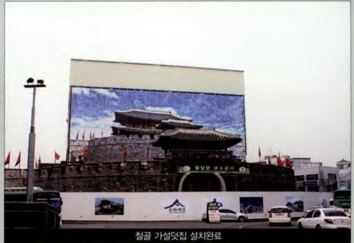
철골 가설덧집 설치완료
