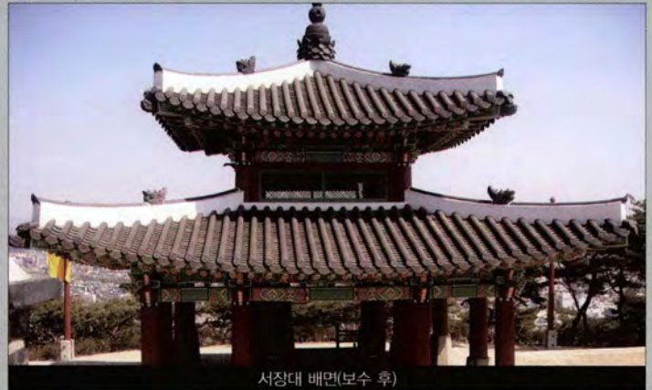
서장대 배면(보수 후)
