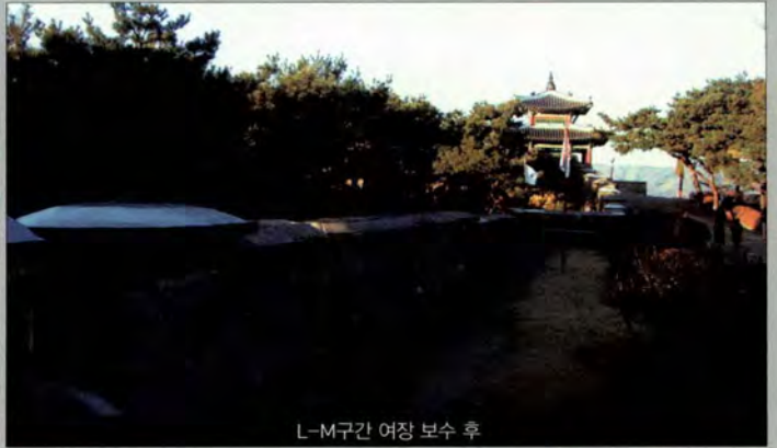
L-M구간 여장 보수 후
