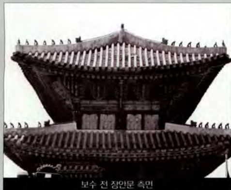
보수 전 장안문 측면
