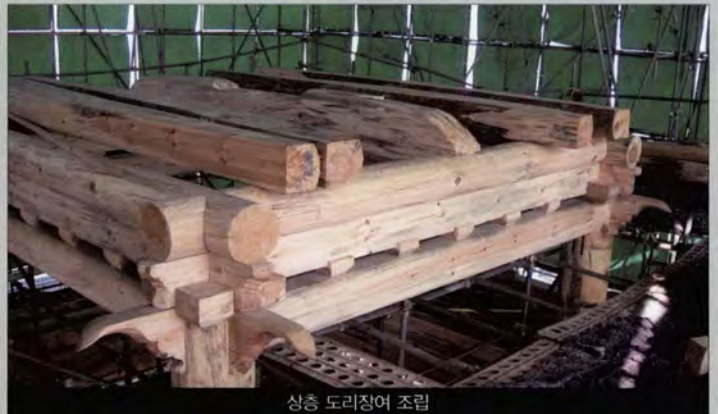
상층 도리장어 조립
