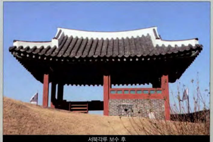
서북각루 보수 후
