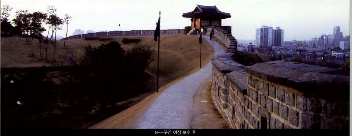
G-H구간 여장 보수 후
