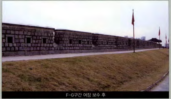
F-G구간 여장 보수 후
