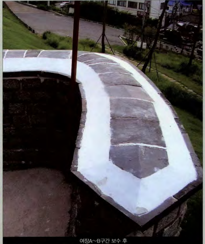
여장A~B구간 보수 후
