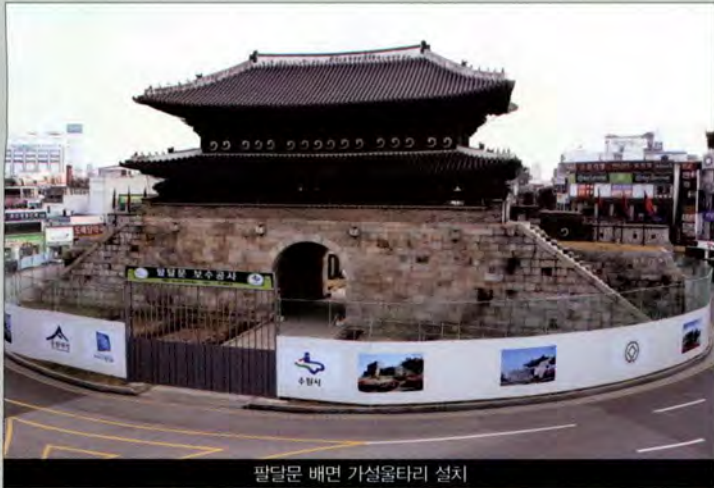
팔달문 배면 가설울타리 설치
