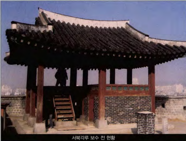
서북각루 보수 전 현황
