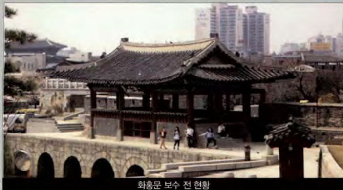
화성문 보수 전 현황
