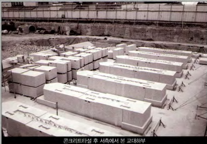
콘크리트타설 후 서측에서 본 교대하부
