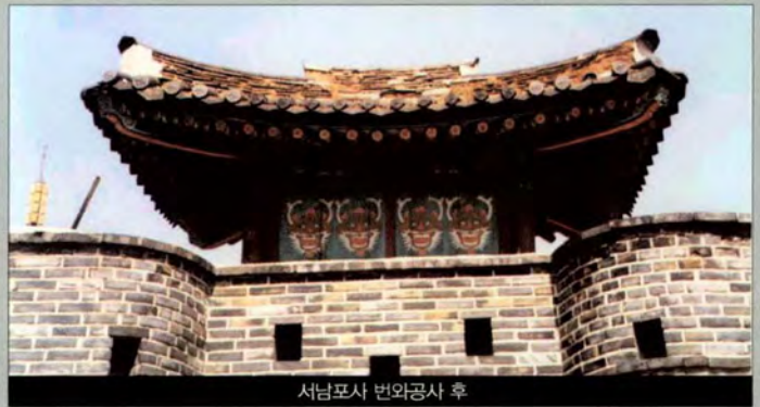
서남포사 번와공사 후
