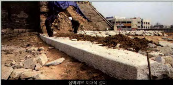
성벽외부 지대석 설치
