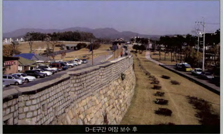
D-E구간 여장 보수 후
