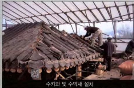
수기와 및 수막새 설치
