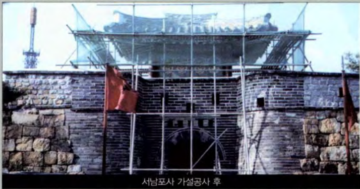
서남포사 가설공사 후
