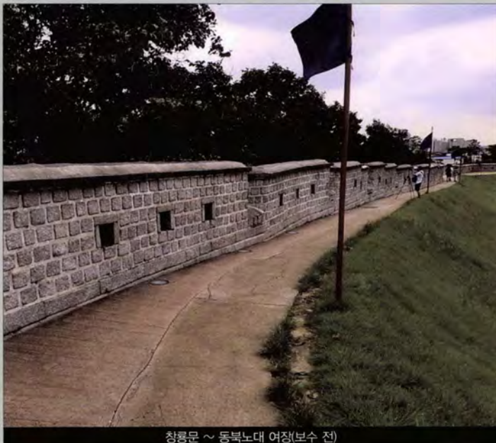
창룡문 ~ 동북노대 여장(보수 전)
