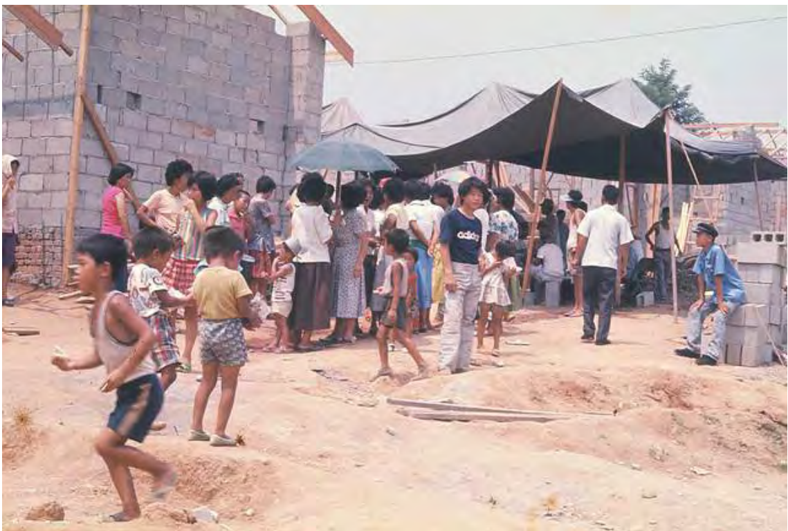
한창 건설 중인 복음자리 마을
