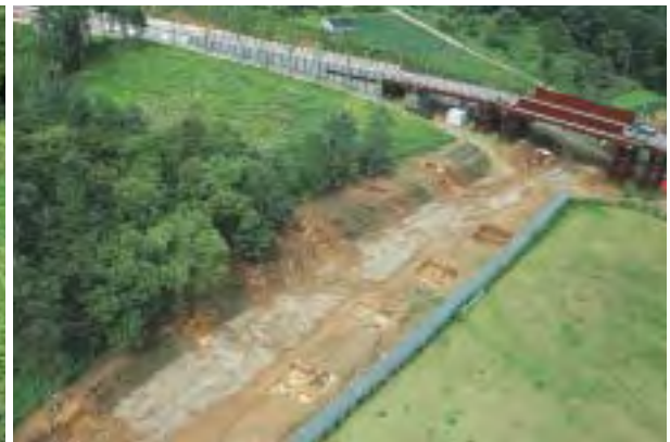
3. 철도 이설 후 전경
