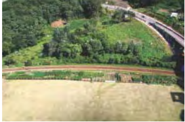
〈사진 Ⅲ-2〉 경춘선 철거 전 전경
