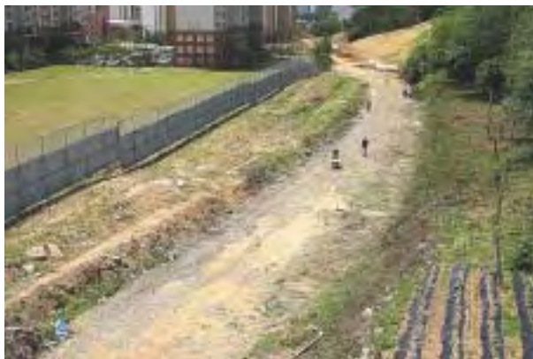
〈사진 Ⅲ-3〉 경춘선 철거 후 전경
