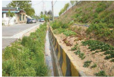
[ 제3경인고속도로 법면 및 배수로 ]
