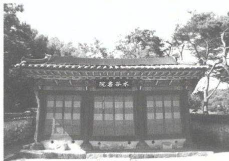
수곡서원의 중심건물인 사우 전경
