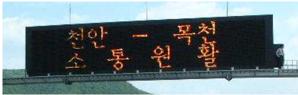
<그림 3-1> 고속도로에 설치된 VMS
