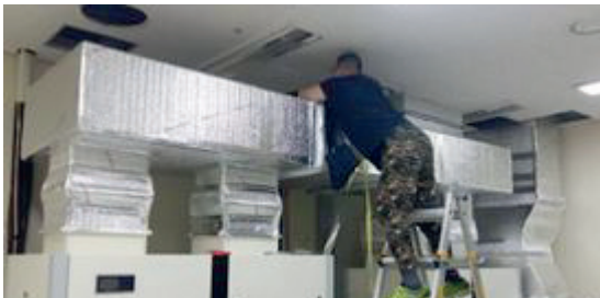
(수장고전실 향온항습기 설치공사)
