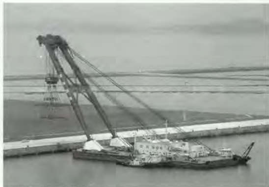
평택항 서부두 건설
