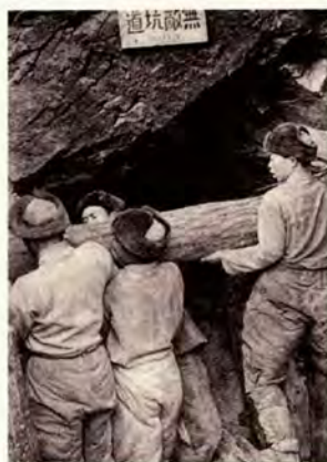
지하 만리장성 공사를 벌이고 있는 중국군 병사들(출처 : 중국해방군화보사)
