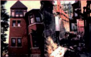
△旧トーマス邸(被災状況)
