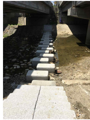
(f) 서수원IC RAMP-F교(B교 접속) 하부 징검다리
