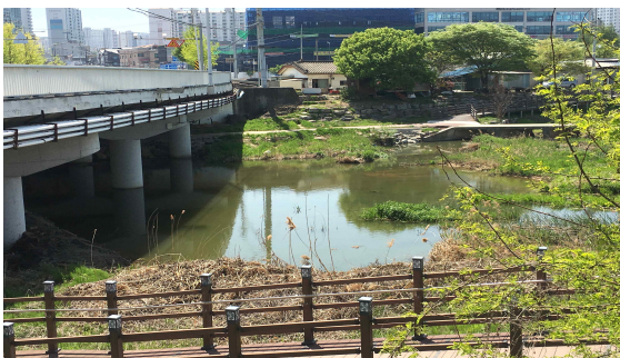
(a) 금곡교 및 상류 전경
