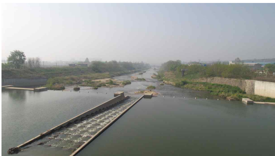
(a) 황계교(대황교보) 국가하천 시점 하류부 전경(16+280)
