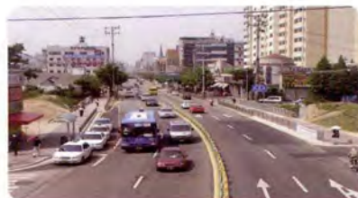
▲ 방호벽 철거 후
